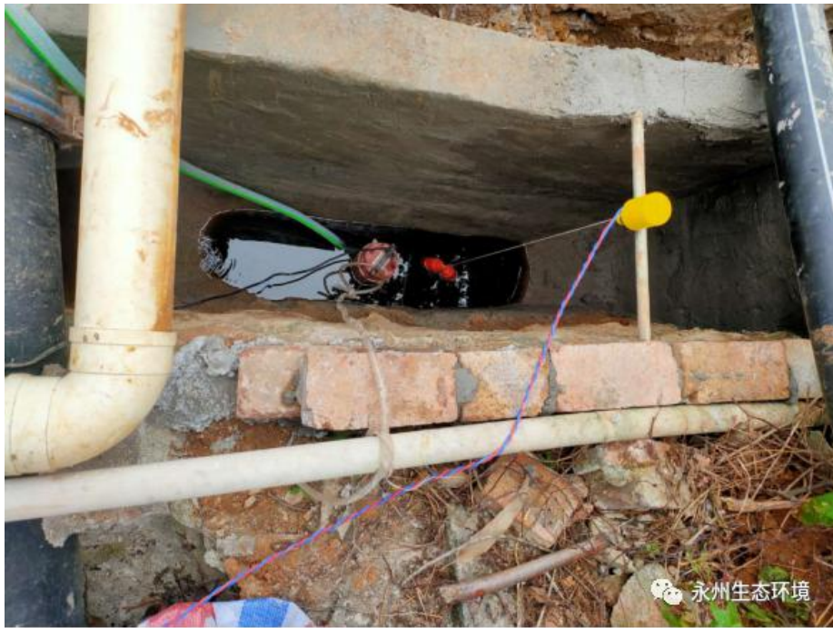
新建渗滤液收集池
