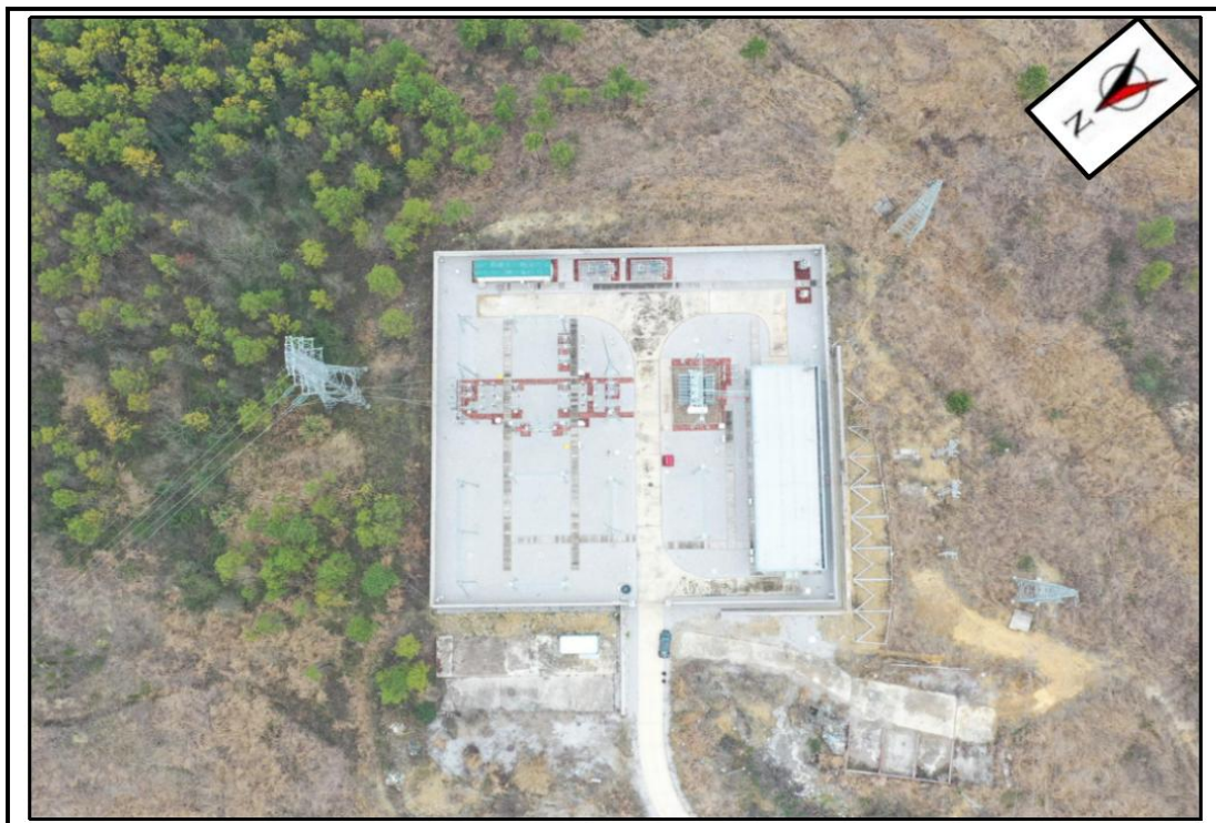
图 3-2 新田武当 110kV 变电站厂界环境现状
