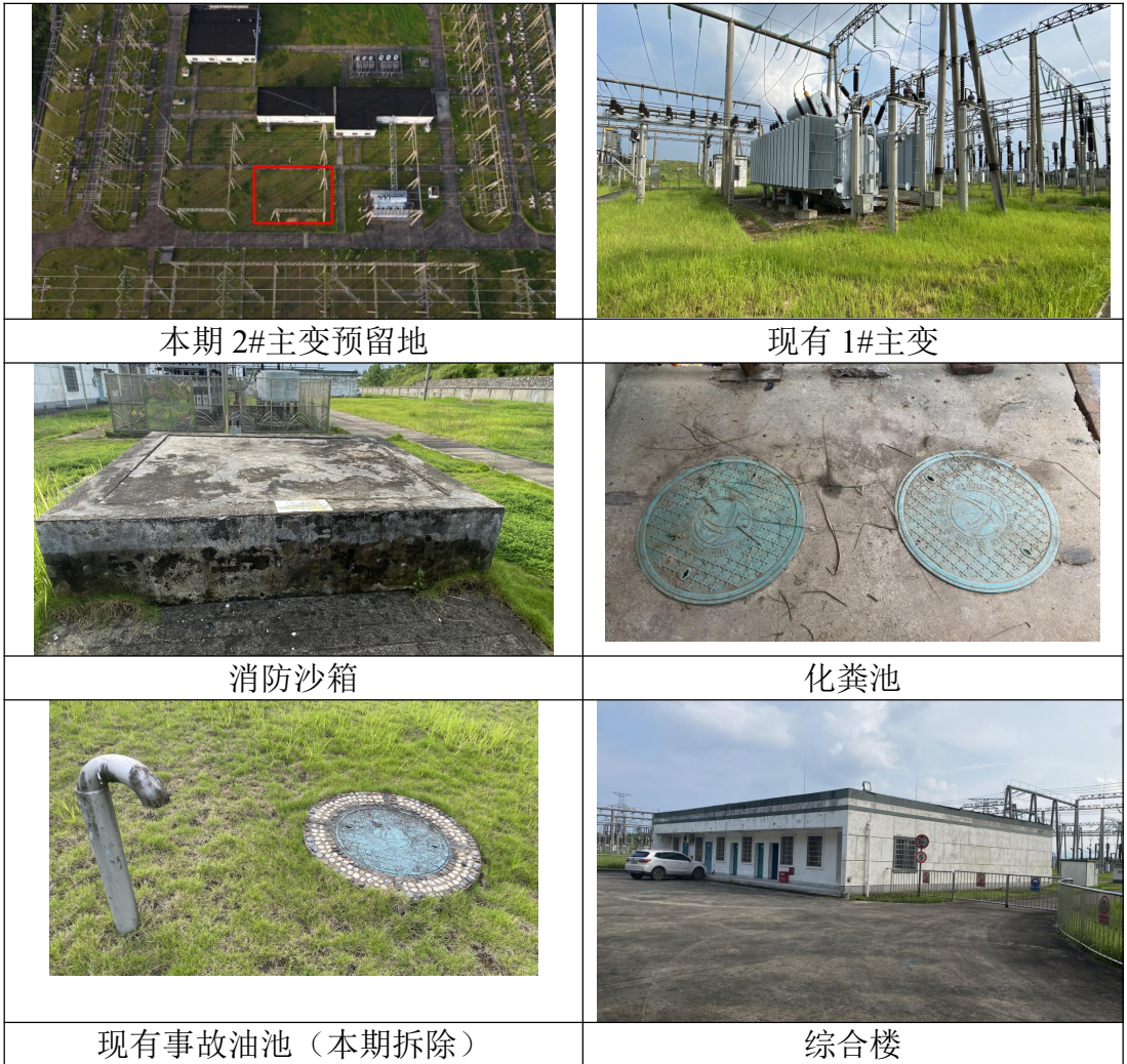
图 2-1 变电站站内环境现状
