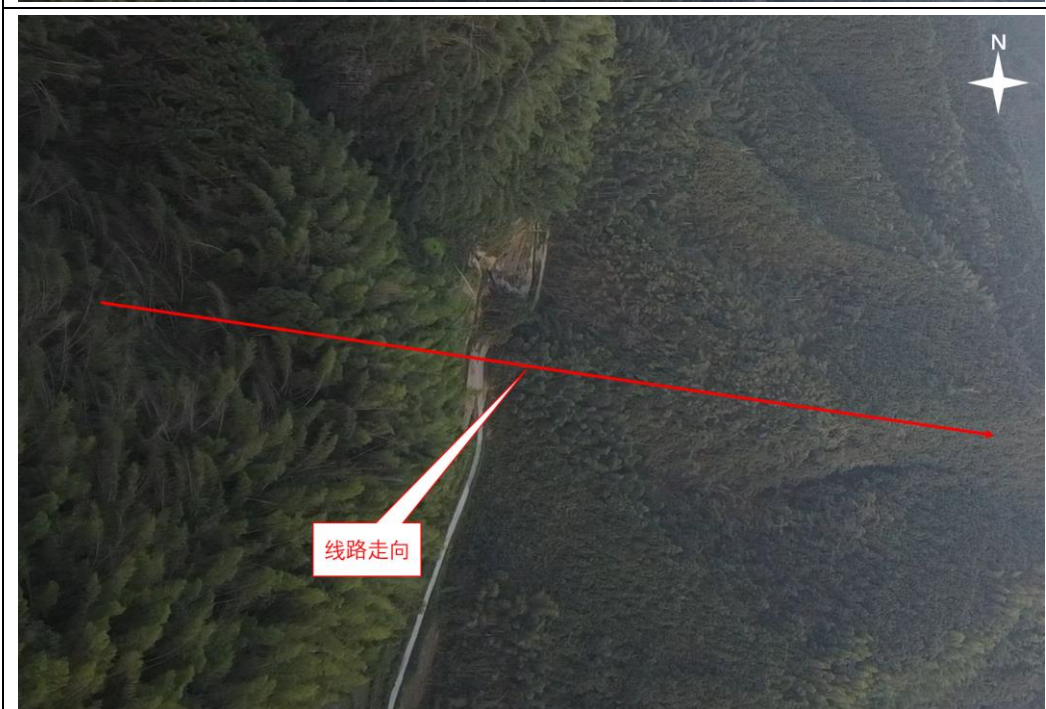
本工程部分输电线路段生态环境现状
