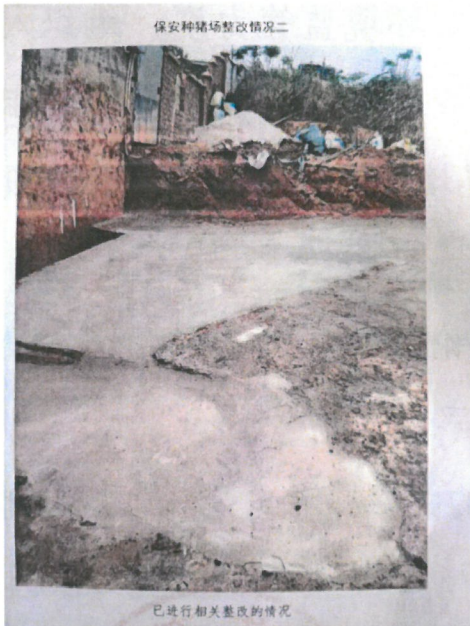
对猪场地面进行清理、硬化
